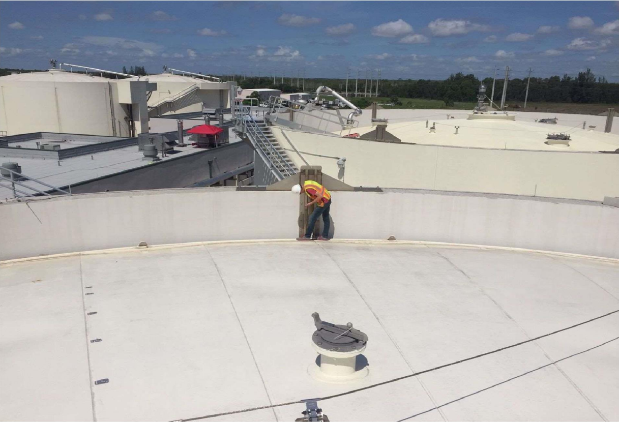
Digester M2 Lid Testing
