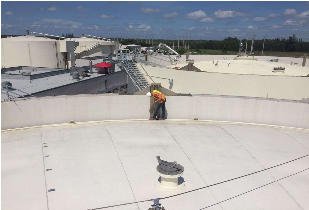
Digester M2 Lid Testing
